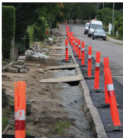
Figur 5. Opretning af kantsten på Harboørevej i Vanløse.
