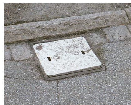
Figur 2. Midlertidig afblænding af nedløbsbrønd med en stålplade. Projekt i Gentofte 2010.
