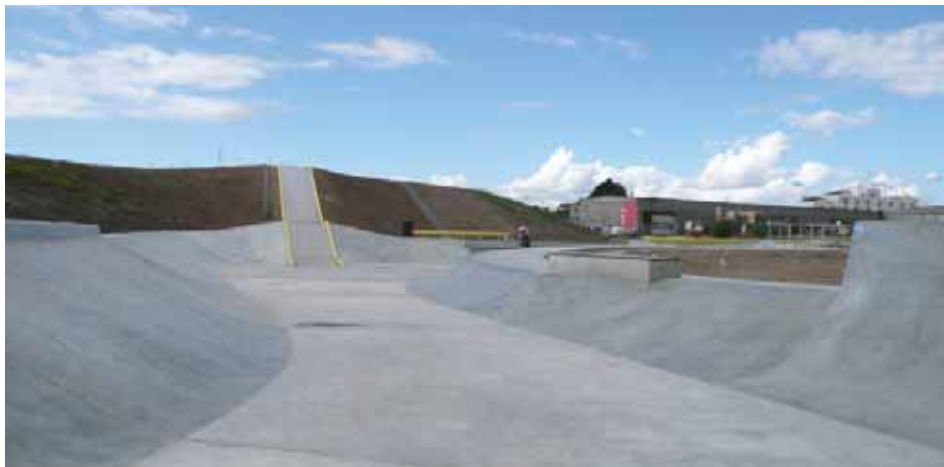
Rabalderparken i Roskilde er et af de første anlæg i Danmark, som forener regnvandsopsamling med rekreative faciliteter og viser, hvordan en teknisk løsning kan danne udgangspunkt for selvorganiserede aktiviteter og fungere som løftestang for lokalsamfundet.
