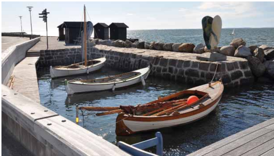
Højvandssikring, arkitektonisk element og siddemulighed på havnen i Løgstør.
