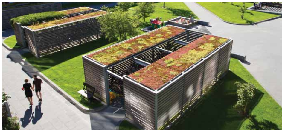
Grønne tage og grønne gårdanlæg kan bidrage til at reducere trykket på kloakkerne ved hverdagsregn men kan oftest ikke stå alene i forbindelse med skybrud. Foto Ursula Bach
