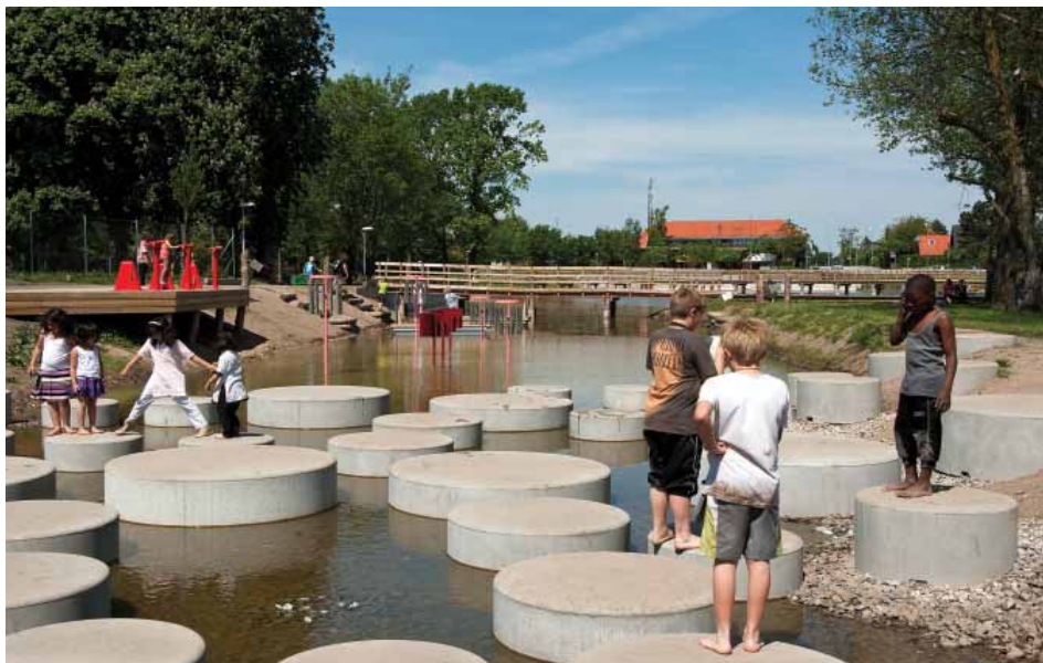
Tåstrup, Selsmose, som er en vand- og aktivitetspark, hvor Høje-Taastrup Kommune kombinerer indsats mod oversvømmelser ifm. store regnvandsmængder og et rekreativt byrum. Foto: Tegnestuen Jens V Nielsen.
