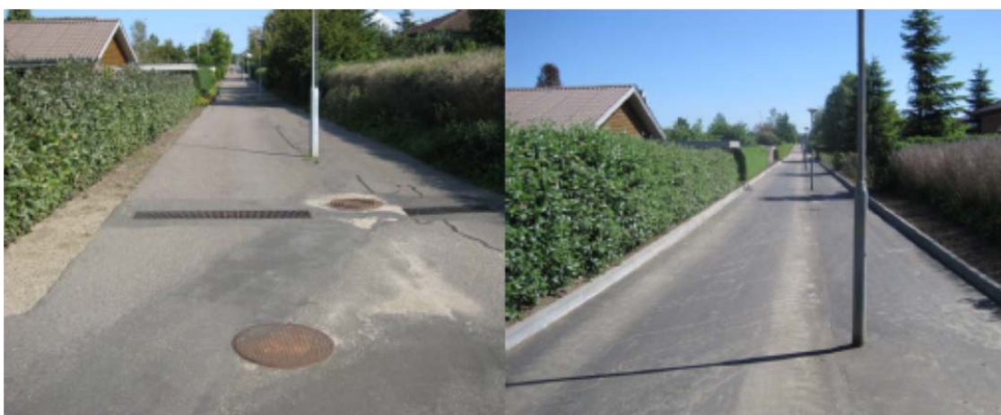
Figur 13. Middelfart Kommune har gennemført et projekt, hvor en cykelsti har fået høje kanter og dermed kan bruges som en vandvej til at lede regnvand hen til et opsamlingsbassin i ekstremesituationer. Kilde: Middelfart Kommune 2012
