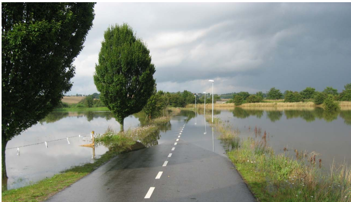
Figur 1. Oversvømmet vej ved Lystrup i Aarhus kommune. Kilde: Aarhus Kommune, Natur og Miljø
