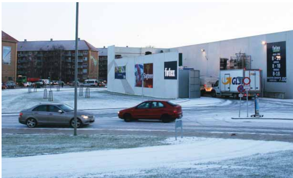
Støjafskærmning ved varemodtagelse.
