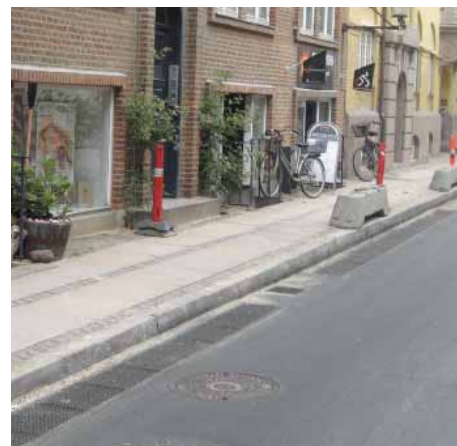
I Ny Kongensgade i det indre København ledes regnvandet ved voldsom regn nu via riste i siden af vejen til større ledninger og her fra til havneløbet. Tidligere kunne vandet ikke slippe væk, selvom Frederiksholms Kanal ligger lige ved siden af. Foto: Københavns Energi
