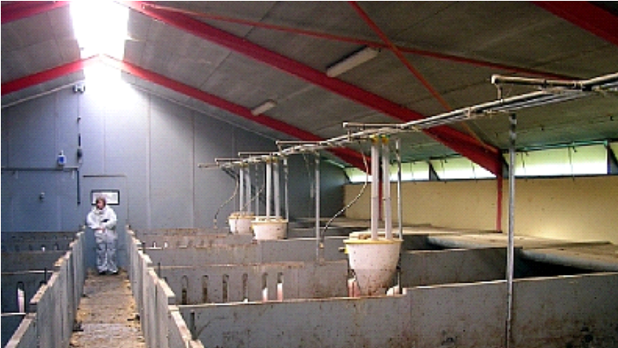
Figur 2. Eksempel på naturlig ventilation, hvor luftindtaget er via regulerbare vægventiler, og luft afgangen er via regulerbar kip (foto: Poul Pedersen, billede nr. 6854)
