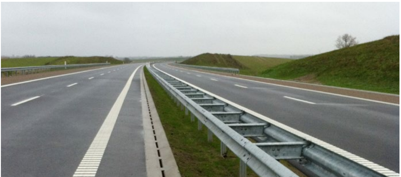
Linjeafvandning ved Kliplev-Sønderborg motorvejen (Foto: Vejdirektoratet)
