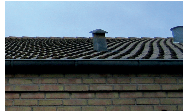
Figur 14 Tagsten der ligger i S-form, som afspejler spærhovedernes form.
