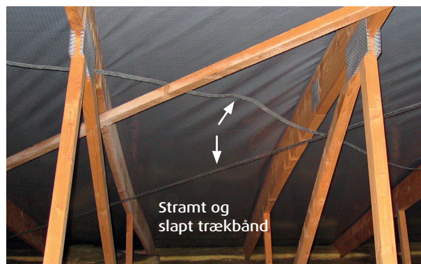
Figur 8 Stramme trækbånd i en retning og slappe i den anden skyldes at trækbåndene virker afstivende i fraværet af et afstivende element. Foto: Palsgaard Spær A/S.
