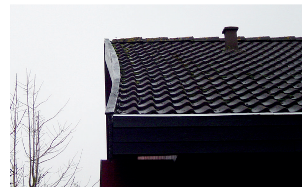
Figur 9 Vindskeden krummer som følge af udbøjning af spærhoveder.
