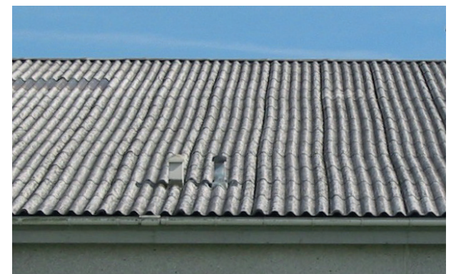
Figur 15 Tagplader, der ligger i S-form, skyldes ofte at gitterstængerne ikke er afstivet eller at skråafstivningen af dem mangler.
