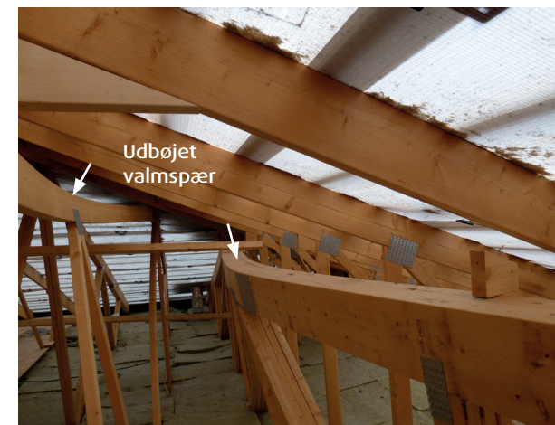
Figur 20 Hanebånd i flerdobbelt valmspær, der har fået stor udbøjning på grund af utilstrækkelig fastholdelse. Foto: Arne Elkær A/S.
