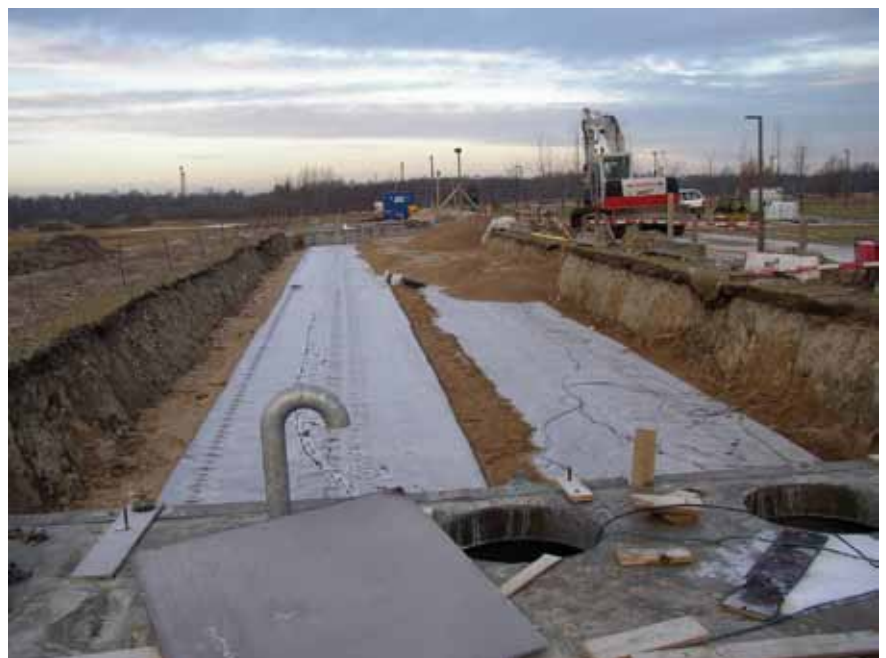
Figur 1. Pilotanlægget i Ørestad 2006, under etablering. Indesluttet i vandtætte membraner ligger til højre DPF-6-Lag, og til venstre DPF-18-Lag, begge 3,4 m brede og 49,5 m lange. Indsat foroven er en prøveserie af vejvand under rensning i DPF-18-Lag, udtaget på en regnvejrsgang i januar 2007. Prøven længst til venstre er indløbsprøven (0 m), mens prøven længst til højre er udløbsprøven (50 m). De 8 prøver derimellem er udtaget gennem små sondeslanger indlagt i udvalgte højporøse lag (strømningslag) i afstandene 1 m, 10 m, 20 m, 30 m, 40 m og 49 m. Indholdet i suspenderet stof falder fra knap 400 mg/L til omkring 2 mg/L over de 50 m.
