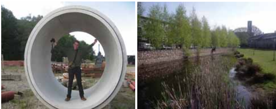
Figur 2. To blandt flere mulige løsninger til imødekommelsen af mere afvandskapacitet omfatter (til venstre) større rør og (til højre) aktivering af byens landskab for tilbageholdelse, nedsivning og fordampning af regnvand.
