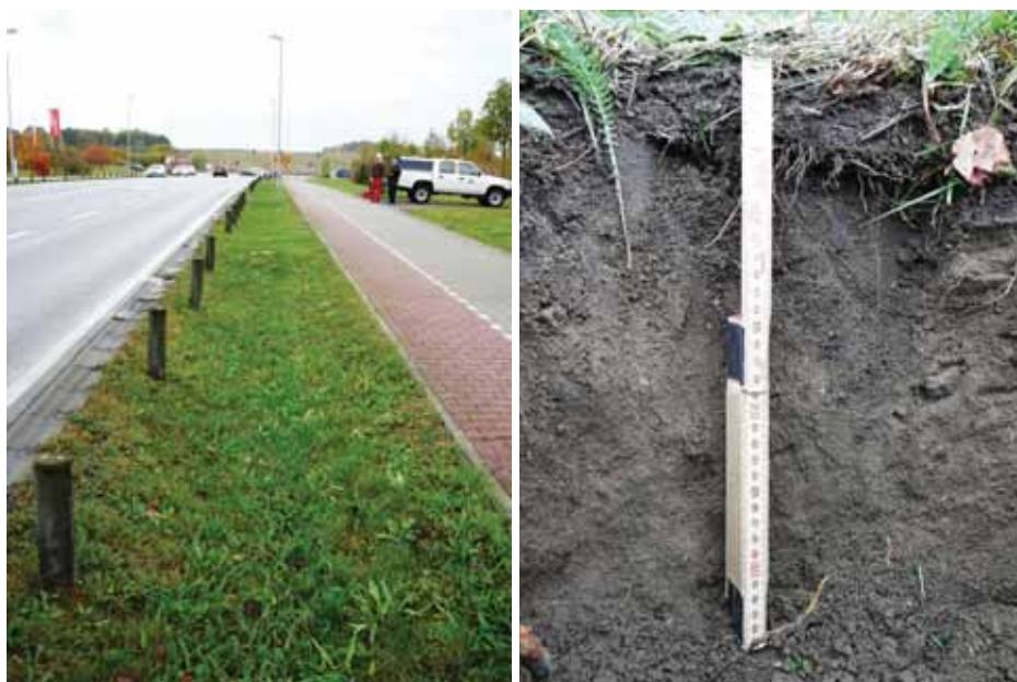
Figur 13. Til venstre: Billede af tysk vadi (Mulden-Rigolen system) ved indfaldsvej til industrikvarter i Hoppegarten ved Berlin. Til højre: Jordprofil af de øverste 30 cm i infiltrationssystemet. Jorden er, som det ses, meget ensartet, og der er livlig aktivitet i form af flora og mikrofauna.
