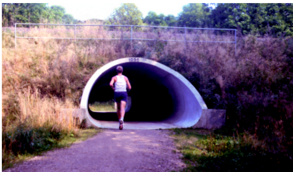
Underføring med et tiltalende udseende
