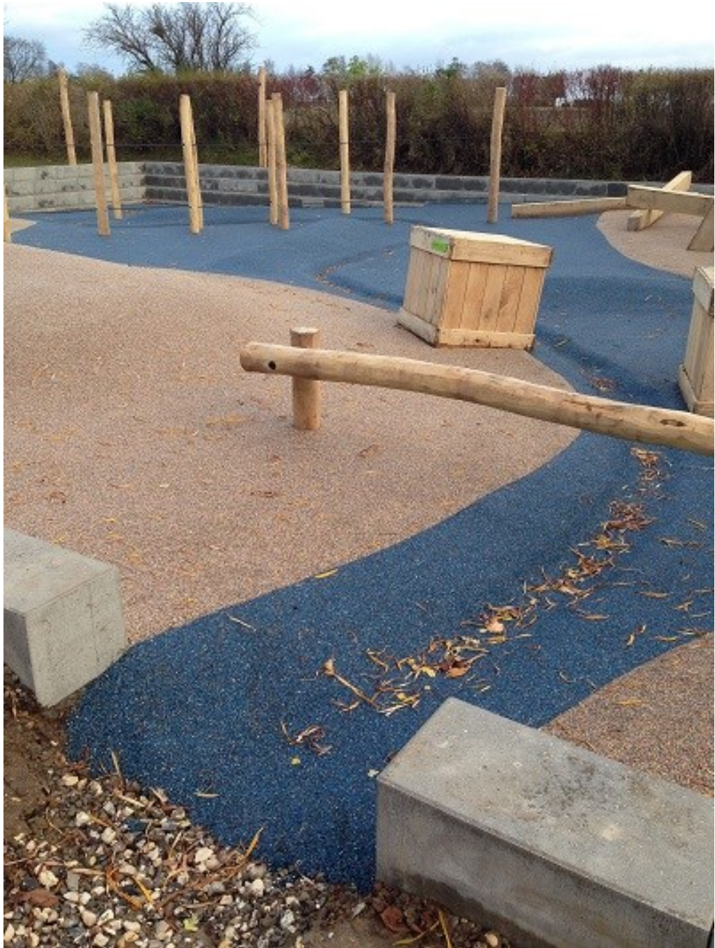
FIGUR 3 FOTO AF MULTIRUM MED SKYBRUDSSIKRING – ANLAGT OKTOBER – NOVEMBER 2015
