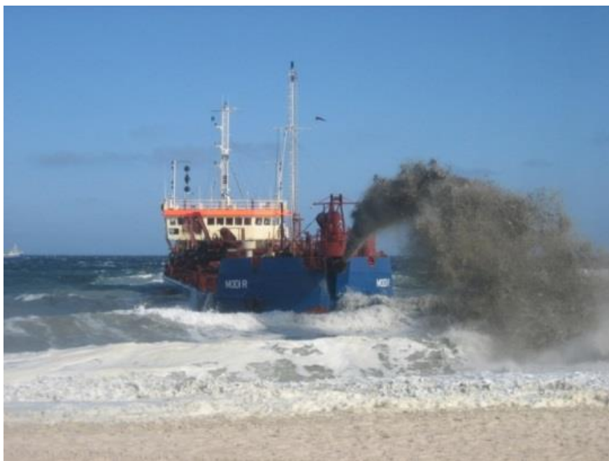
Figur 3.9 Strandfodring ved indpumpning af sand i en stråle ('Rainbow') fra sandsugeren. Rohde Nielsen.
