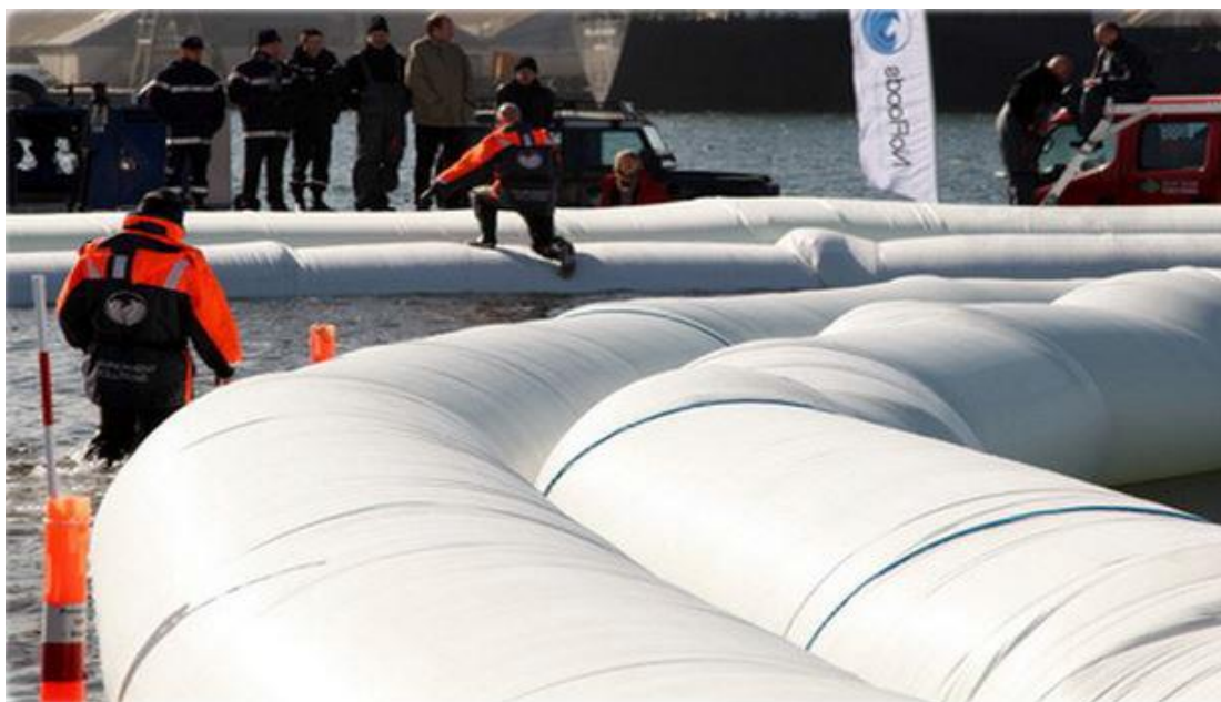
Figur 3.25 "Water tube" som mobil højvandsbeskyttelse, Ref. /6/.
