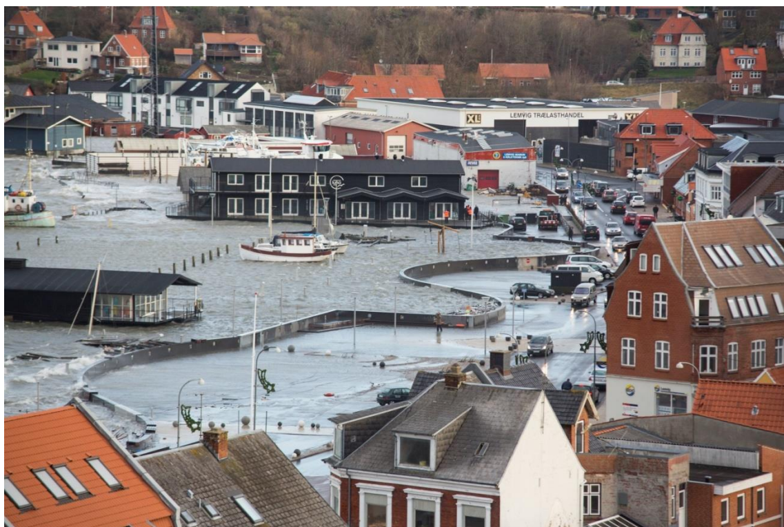
Figur 3.23 Højvandsmuren i Lemvig i funktion under Stormen Bodil.
