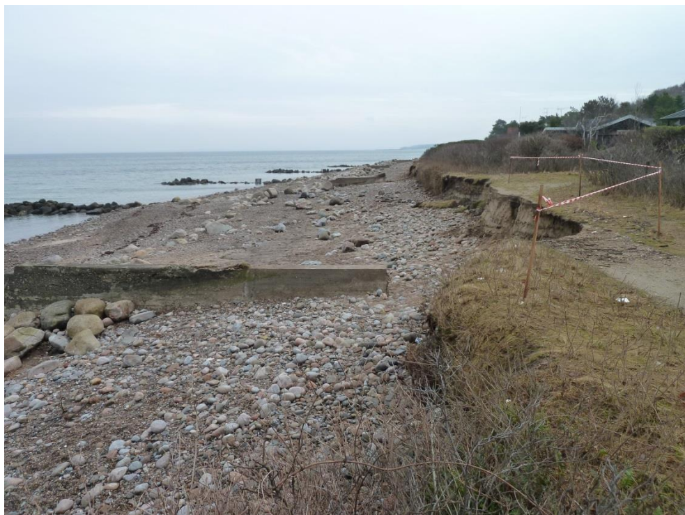
Figur 2.26 Fotos efter Stormen Bodil d. 6.12.2013, som medførte ekstremt højvande på 1,9 m langs Sjællands Nordkyst. Øverst: Jævnt fordelt akut erosion langs klitrækken NØ for Liseleje. Nederst: Skrænterosion langs Villingebækstien, bemærk at højden ikke har haft nogen virkning.
