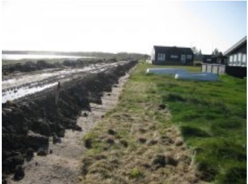
Digebyggeri ved As Vig 2011. Diget stod sin prøve i 2013, hvor vandstanden nåede op på 1,55 meter. Foto: As Vig Syd Digelag
