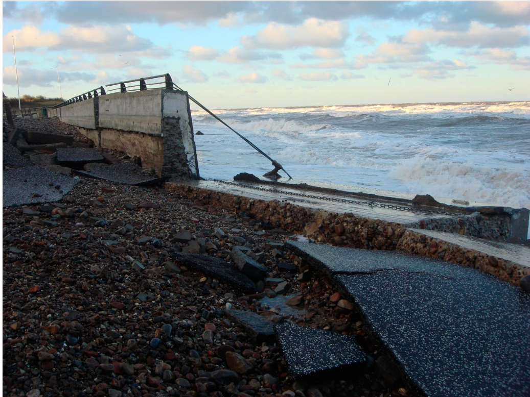
Stormen Bodil, december 2013, underminerede den hårde kystbeskyttelse.
