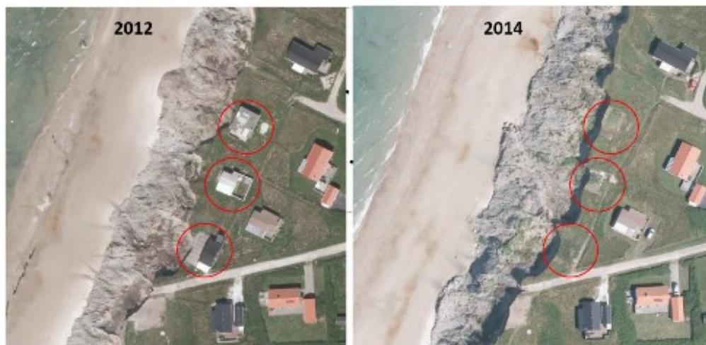
FIGUR 17 3 HUSE NEDTAGET SOM FØLGE AF EROSION, NR. LYNGBY.
