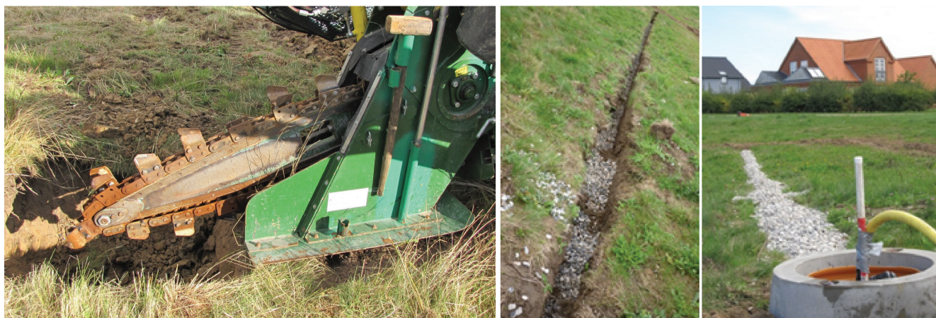
Figur 2. Etablering af terrænfaskine (dyb grusrende). Venstre: Frontmonteret kædegraver. Midten: Delvist grusfyldt rende. Højre: Færdig rende 0,17 m bred, 15 m lang og 1 m dyb. Tilløbsbrønd ses forrest i billedet.
