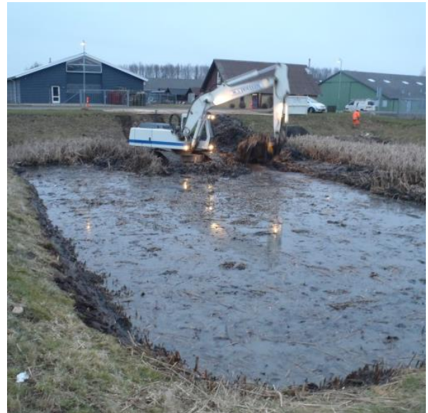
Figur 6-4: Opgravning af sediment fra vandfyldt bassin ved brug af gravemaskine, der kører på bunden af vandfyldt bassin.
