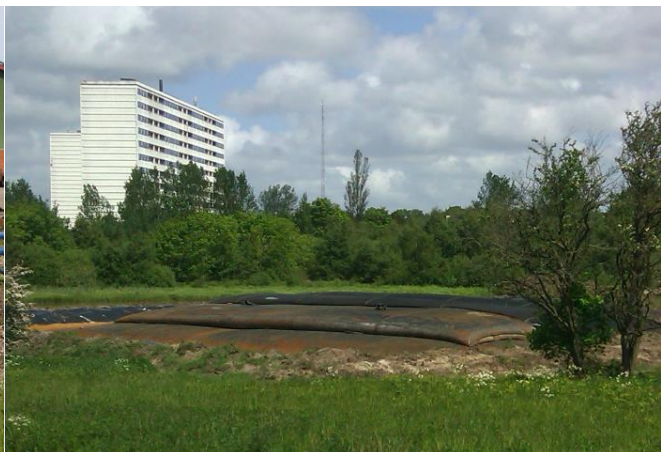
Figur 6-15: Afvandingspose i brug
