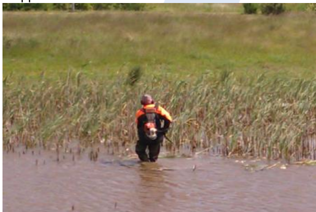
Figur 5-13 Elektrisk le til brug i regnvandsbassin
