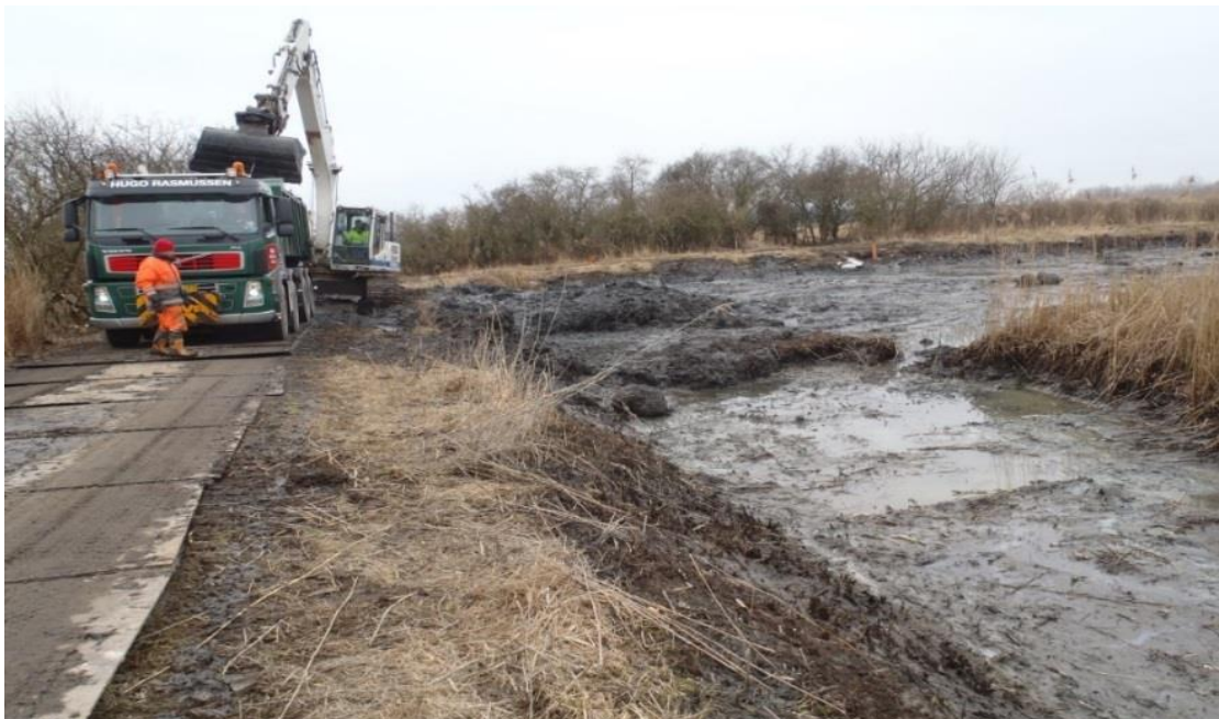
Figur 6-10 FØR: Sedimentopgravning pågår i et regnvandsbassin i Skælskør
